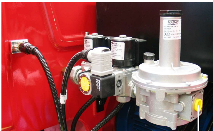
подсоединение к сети распределения газа - 1/2"
