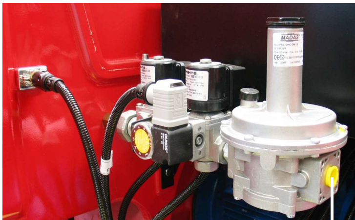
подсоединение к сети распределения газа - 1/2"
