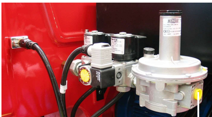
подсоединение к сети распределения газа - 1/2"
