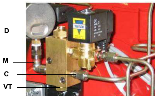
Рис. 12 - Ручной регулятор жидкого топлива
