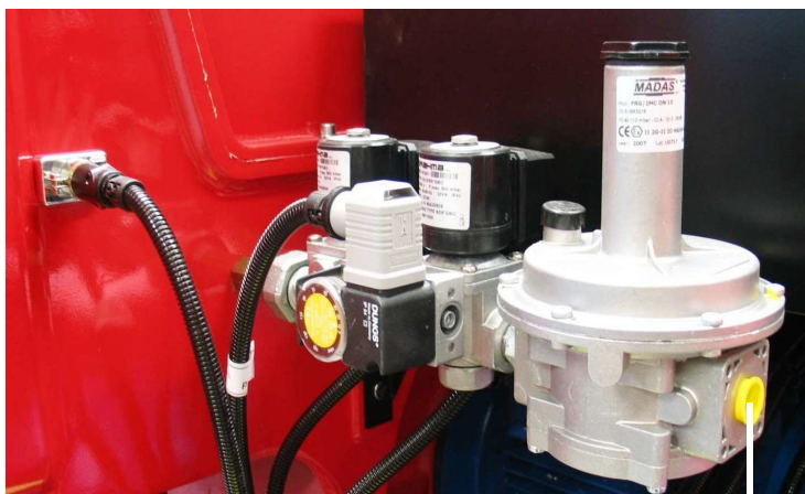
подсоединение к сети распределения газа - 1/2"
