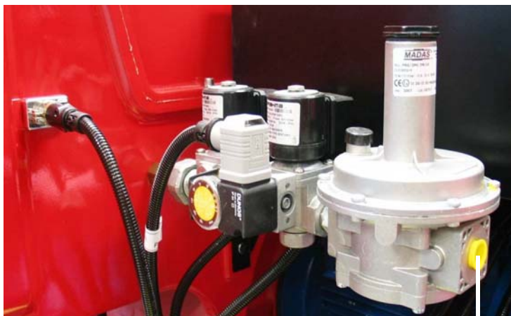
подсоединение к сети распределения газа - 1/2"
