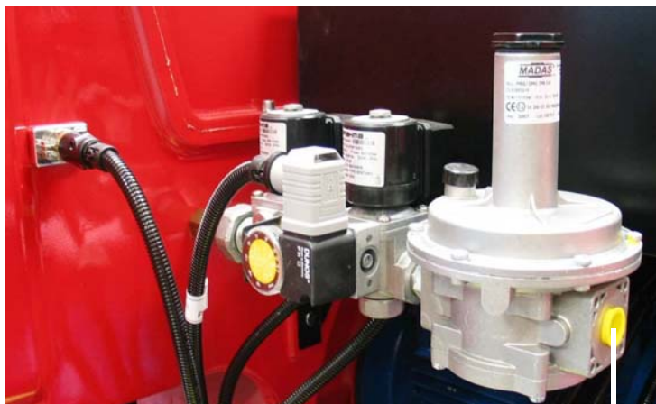
подсоединение к сети распределения газа - 1/2"
