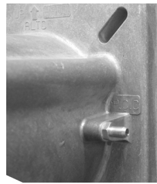
Toma de presión en la cámara de combustión
