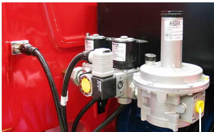
подсоединение к сети распределения газа - 1/2"
