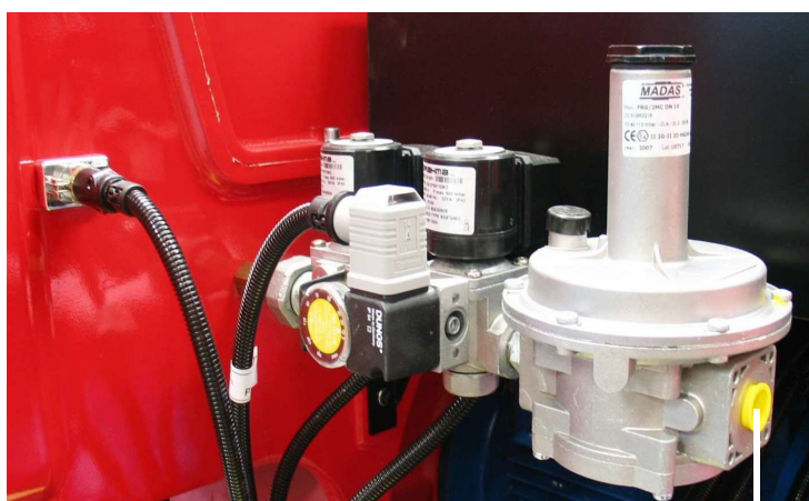
подсоединение к сети распределения газа - 1/2"
