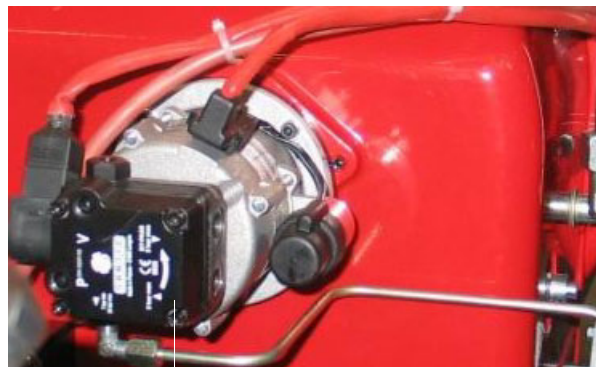
насос дизельной запальной горелки
