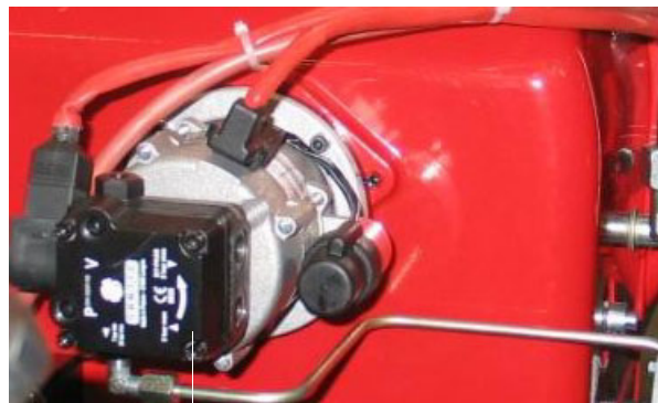
насос дизельной запальной горелки
