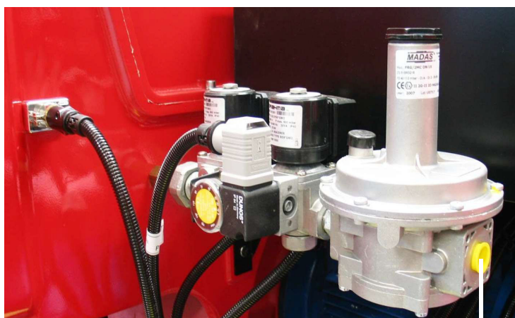
collegamento alla rete distribuzione del gas - 1/2"
