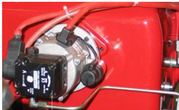
pompa pilota gasolio
