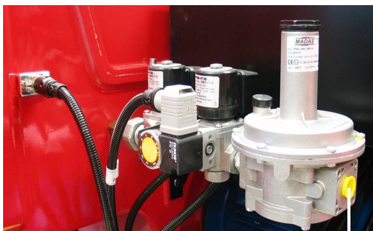
collegamento alla rete distribuzione del gas - 1/2"
