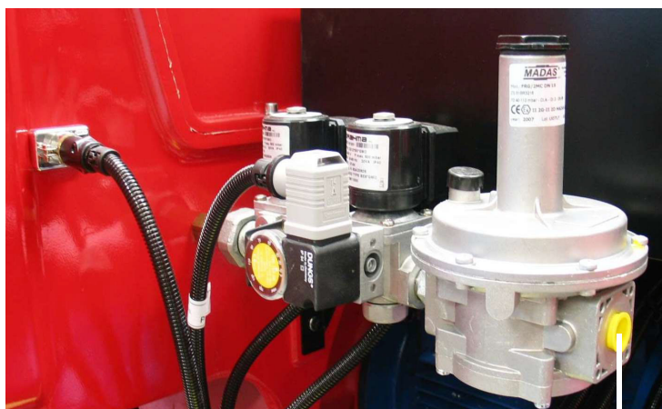
collegamento alla rete distribuzione del gas - 1/2"
