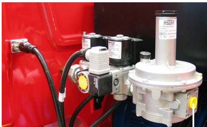
подсоединение к сети распределения газа
