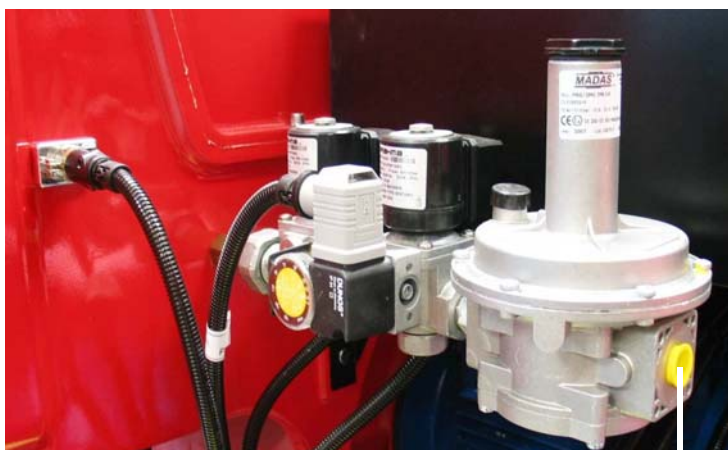
подсоединение к сети распределения газа
