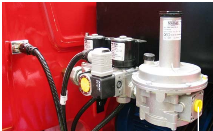
collegamento alla rete distribuzione del gas
