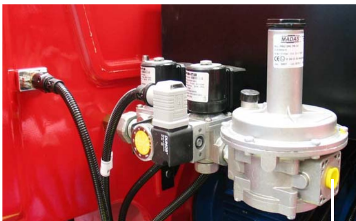
подсоединение к сети распределения газа
