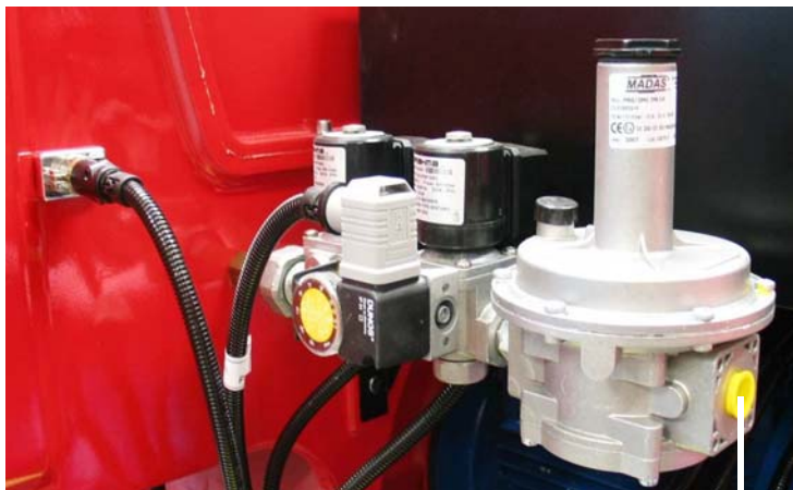
подсоединение к сети распределения газа
