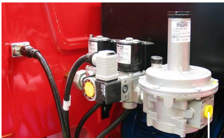
collegamento alla rete distribuzione del gas - 1/2"
