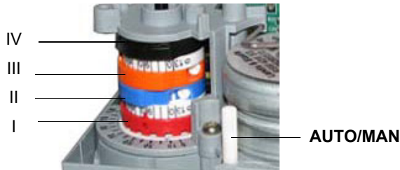
Siemens SQN72.4A4Axx (modelos progresivos y modulantes)
